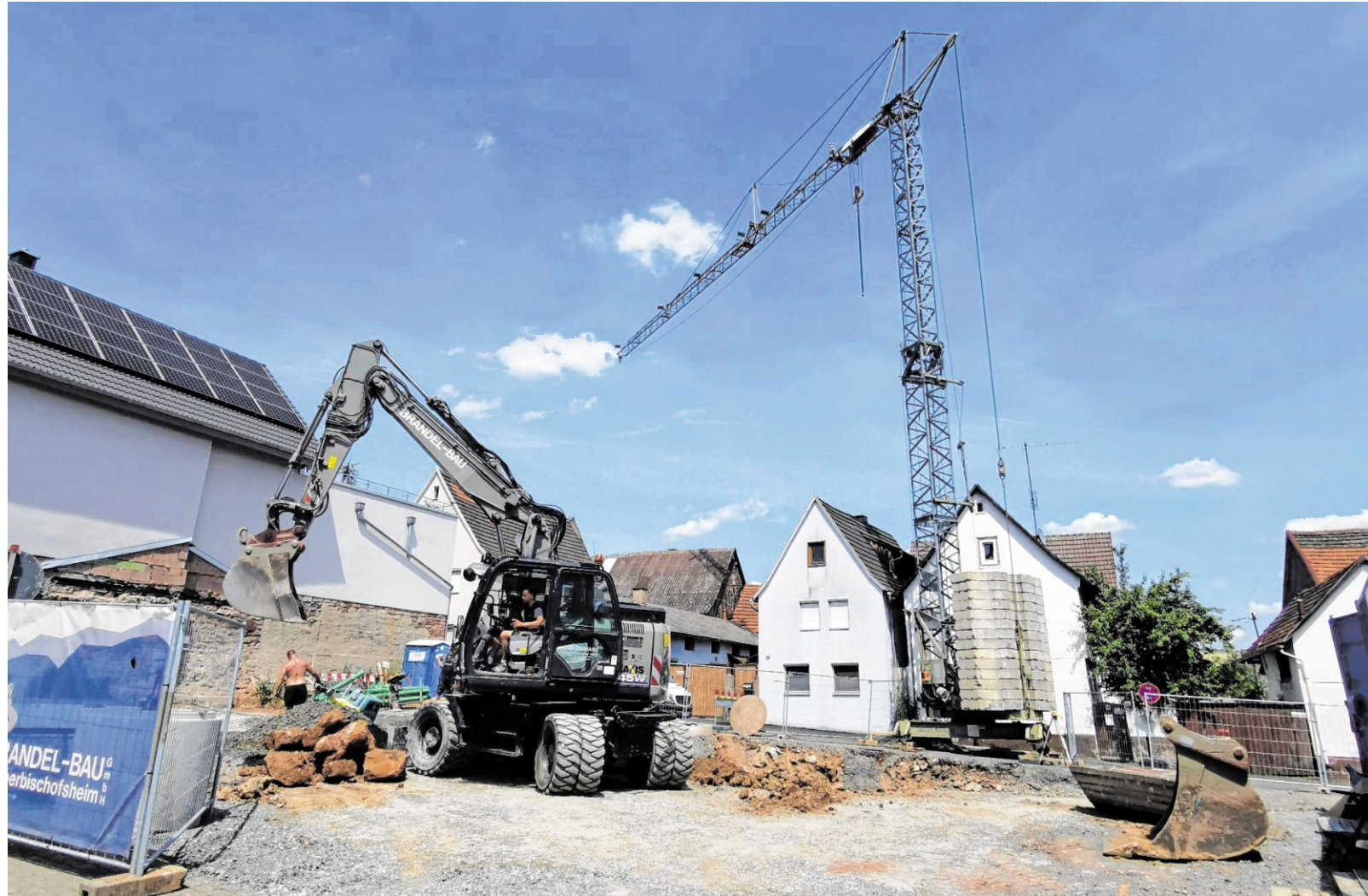
Seit ein paar Tagen wird in der Hauptstraße 54 in Werbach gebaut. Hier soll der neue Finanzpunkt von Volksbank und Sparkasse entstehen.
