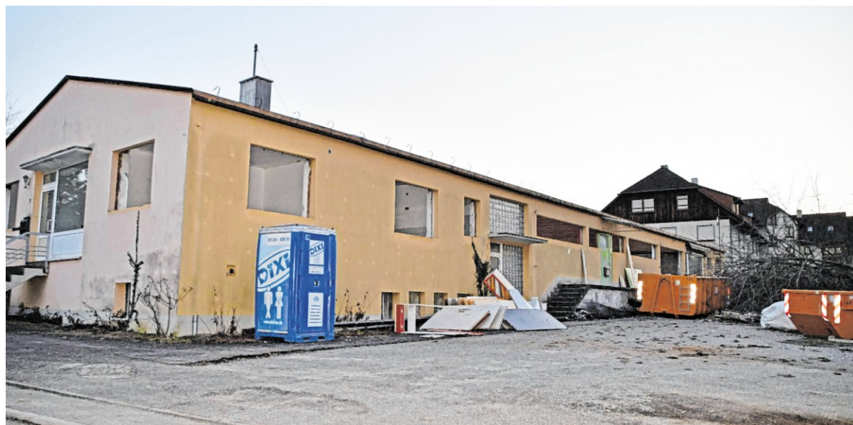
Schon seit längerem steht das Gebäude der ehemaligen Strumpffabrik Harzer leer. In Kürze wird es abgerissen.
