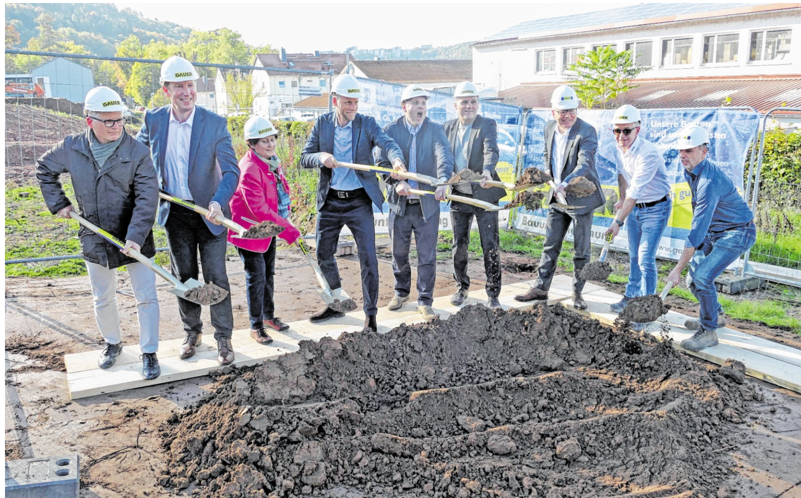
Beim Spatenstich zum neuen Wohnstift auf dem Areal des ehemaligen Diakonissenmutterhauses freuten sich die Projektbeteiligten über den großen Schritt für das Projekt und zugleich die Nähe zum geschichtlichen Ursprung des Wohnstifts.
