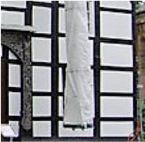
Mit der Einrichtung des 6,39 Meter langen Rettungsschlauches, der 15 000 Euro gekostet hat, hat der Gallusturm nun einen zweiten Rettungsweg erhalten. Damit ist der Anbau einer Rettungsleiter aus Metall, die den historischen Turm optisch verunstalten würde, abgewendet.
