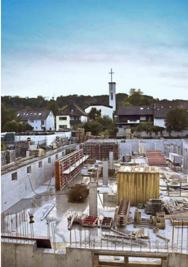
Der Stahlbetonbau nimmt hinter dem Wehrahof langsam Gestalt an. Jetzt entstehen zunächst die Tiefgarage und die Kellerabteile für die Bewohner. Foto: Erika Bader
